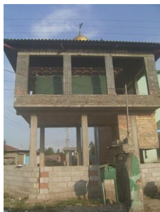
تصویر شماره ۵ هشت- فضای آجری در نمای جنوبی سقائفار (نگارندگان، ۱۳۸۸)
